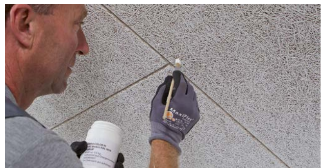
Au cas où des vis non colorées sont utilisées, peindre les têtes de vis avec la peinture délivrée ou une peinture équivalente en utilisant un pinceau fin et une quantité de peinture adaptée. Les têtes de vis doivent être mises à fleur avec la surface des panneaux.
