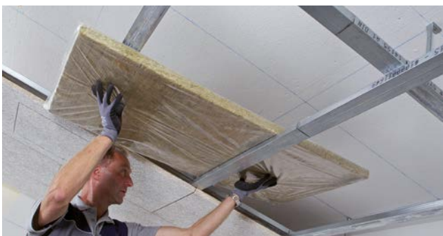
Insérer le revêtement acoustique HERADESIGN® ou d'autres revêtements à effet acoustique étape par étape lors du montage des panneaux acoustiques HERADESIGN®. Couper sur mesure les panneaux muraux absorbants qui seront serrés entre les lattes de bois.
