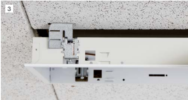
3 Accrocher le plafonnier. Fixer aux profilés en T, profilés CD ou lattes de bois à l'aide des ailes latérales fournies. Adapter la hauteur d'installation du luminaire à la hauteur de suspension existante.
