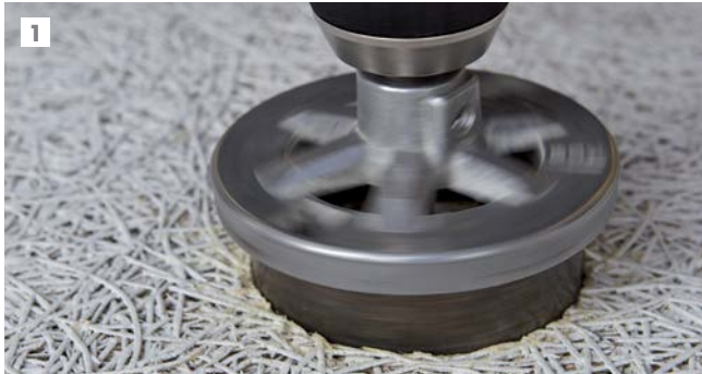
1 Percer une ouverture circulaire pour les spotlights. Le côté visible des panneaux se trouvent en haut.
