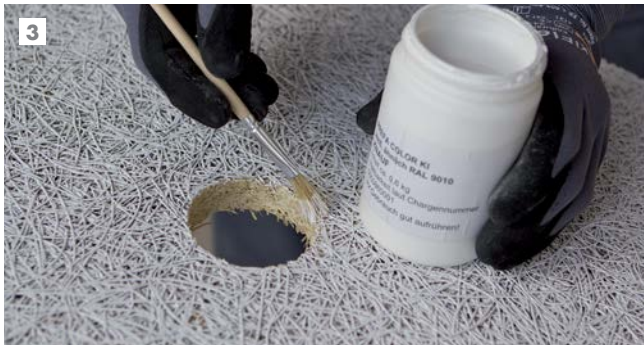
3 Peindre les bords coupés s'ils ne sont pas cachés par un habillage.
