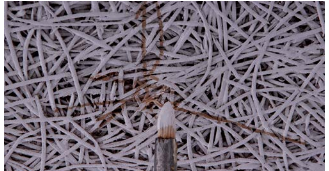
Ruptures de fibres:
