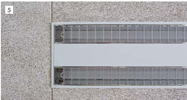
5 Luminaire de cadre installé. Couvrir le joint des panneaux par le cadre d'habillage.
