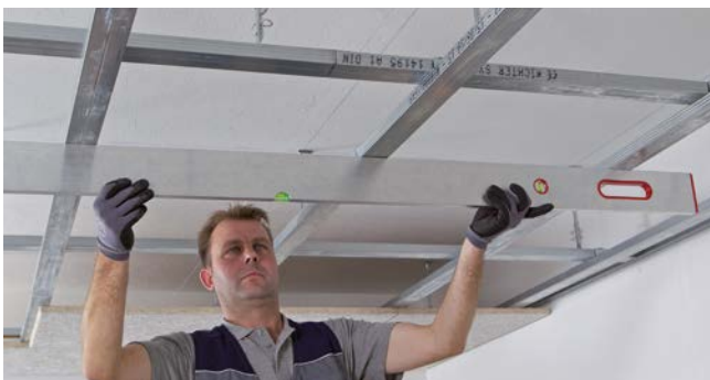
Aligner les profilés CD au niveau à bulle ou au dispositif laser.
