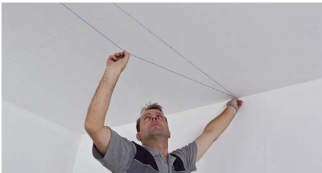
Marquer le cadre de plafond en commençant au centre de la pièce, par ex. à l'aide d'un cordeau à tracer. Assurer une taille identique des panneaux de bord.
