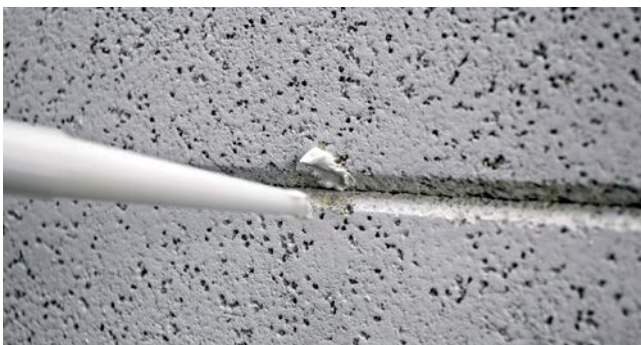
Réhabilitation d'imperfections mineures sur panneaux acoustiques HERADESIGN® micro ou HERADESIGN® plano:
