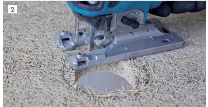
2 Couper une ouverture au moyen d'une scie sauteuse. Le côté visible des panneaux se trouvent en bas.
