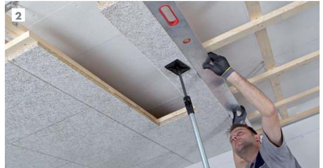
2 Monter les bandes d'ajustement.
