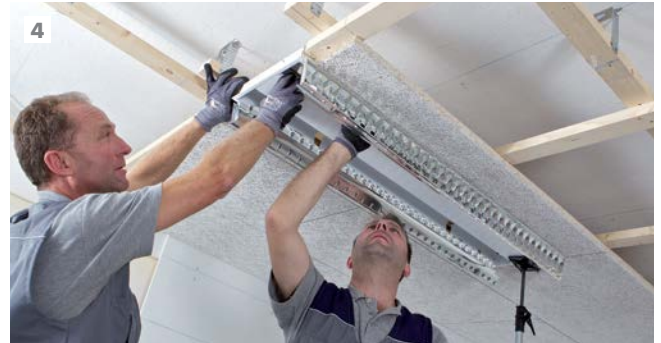
4 Alternativement: Fixer le plafonnier aux lattes de bois latérales ou profilés CD avec des vis ou le fixer directement au plafond.
