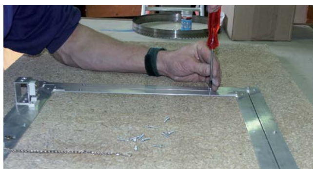
Visser la plaque de couverture avec au moins 2 x 4 vis de 4,5 x 20 mm par cadre de 40 x 40 ou 2 x 6 pièces en cas de 60 x 40 cm et Heraklith BM PU ou colle polymère au cadre intérieur.
