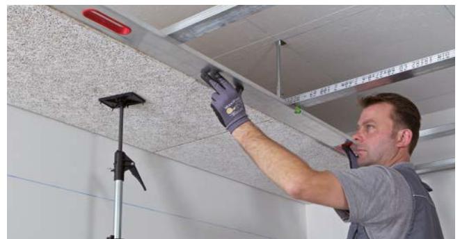
Aligner les lignes des panneaux à la latte de pose. Les joints des panneaux doivent être disposés au centre du profilé. Les joints libres, flottants de panneaux ne sont pas admissibles ! Respecter le sens de pose indiqué au dos du panneau lors du montage des panneaux carrés.
